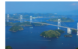
来島海峡大橋
