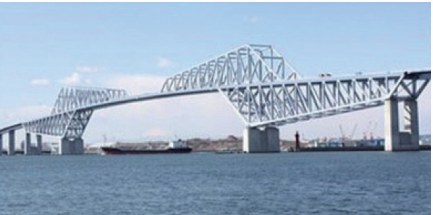
東京ゲートブリッジ
