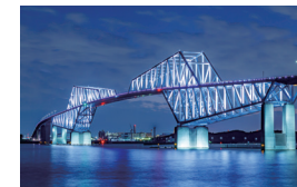
東京ゲートブリッジ
