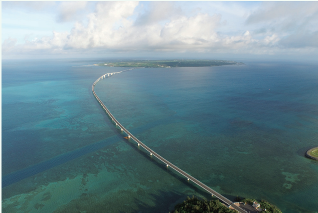
伊良部大橋 / 沖縄県宮古島市
