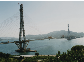
多々羅大橋
