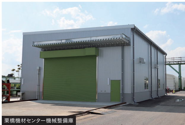
栗橋機材センター機械整備庫
