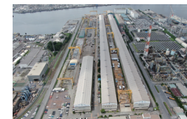
宮地エンジニアリング(株)千葉工場
