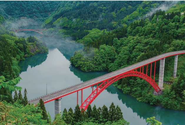
利賀大橋 / 富山県南砺市
