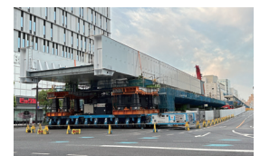
広島広島駅高架化関連工事
