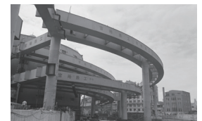
江戸橋ジャンクション(架設中)
