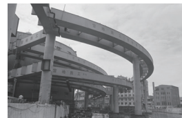
架設中の江戸橋ジャンクション
