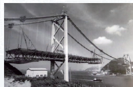
架設中の関門橋
