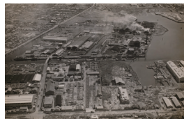
砂町第1・第2工場
