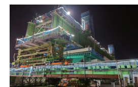
中国自動車道 石橋跨線橋(下り線)
