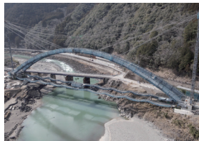
鎌瀬橋の架設状況
