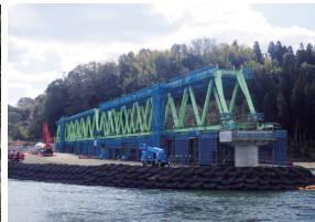
球磨川第四橋梁(TT3/TT4)の架設状況
