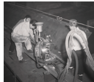
波田工場での作業の様子
