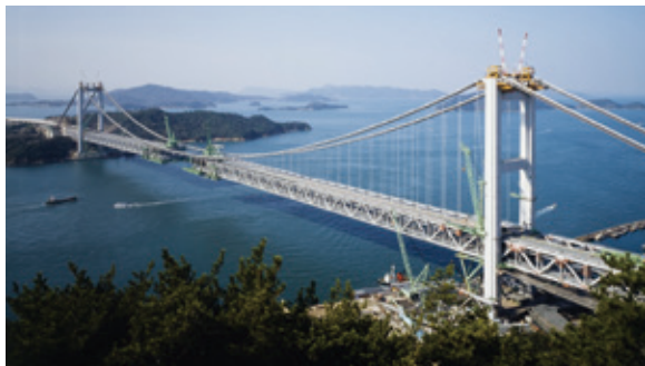
架設中の下津井瀬戸大橋
