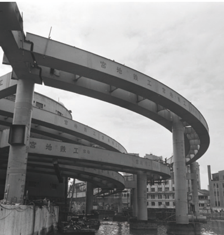
建設中の江戸橋ジャンクション
