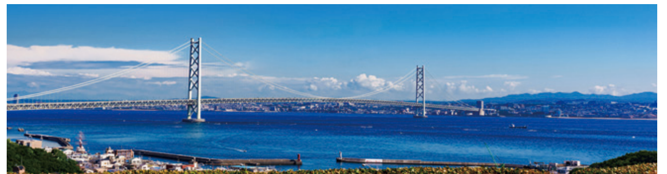
明石海峡大橋
