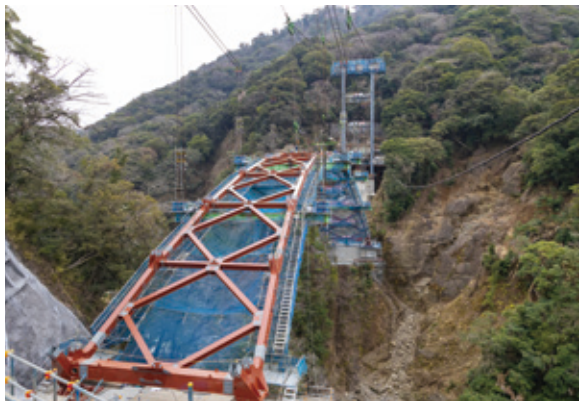
ケーブルクレーン架設
