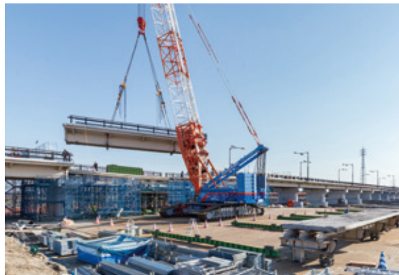
クローラークレーンによる撤去
