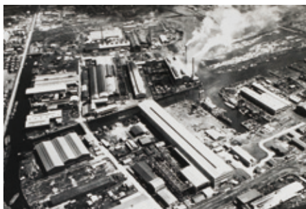
砂町第1・第2工場
