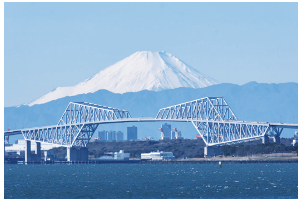
東京ゲートブリッジ
