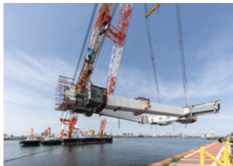
大型FCによる主塔浜出し
