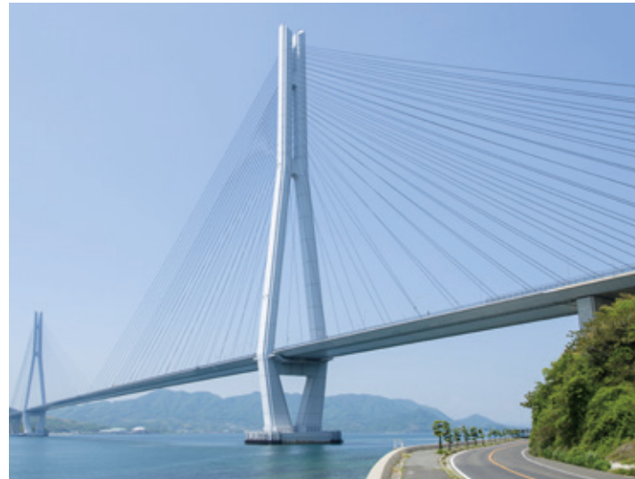
多々羅大橋
