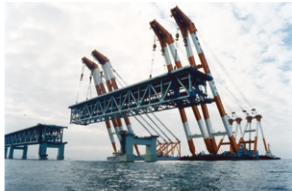
大型FCによる大ブロック一括架設
