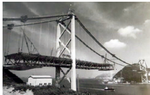
架設中の関門橋
