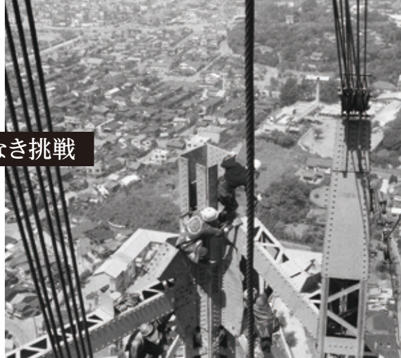
東京タワー建築作業の様子
